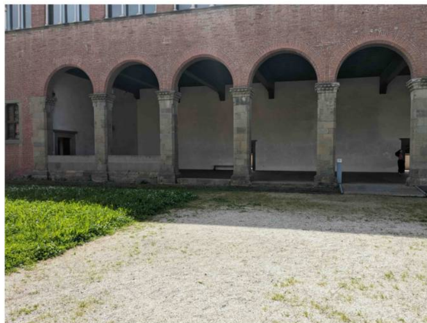
Percorso scoperto su ghiaino Prevedere miglioramento del fondo
