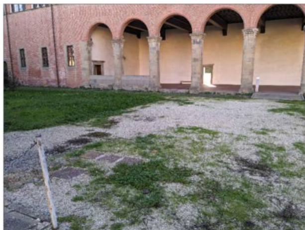
FOTO STATO ATTUALE - RAMPA INGRESSO
