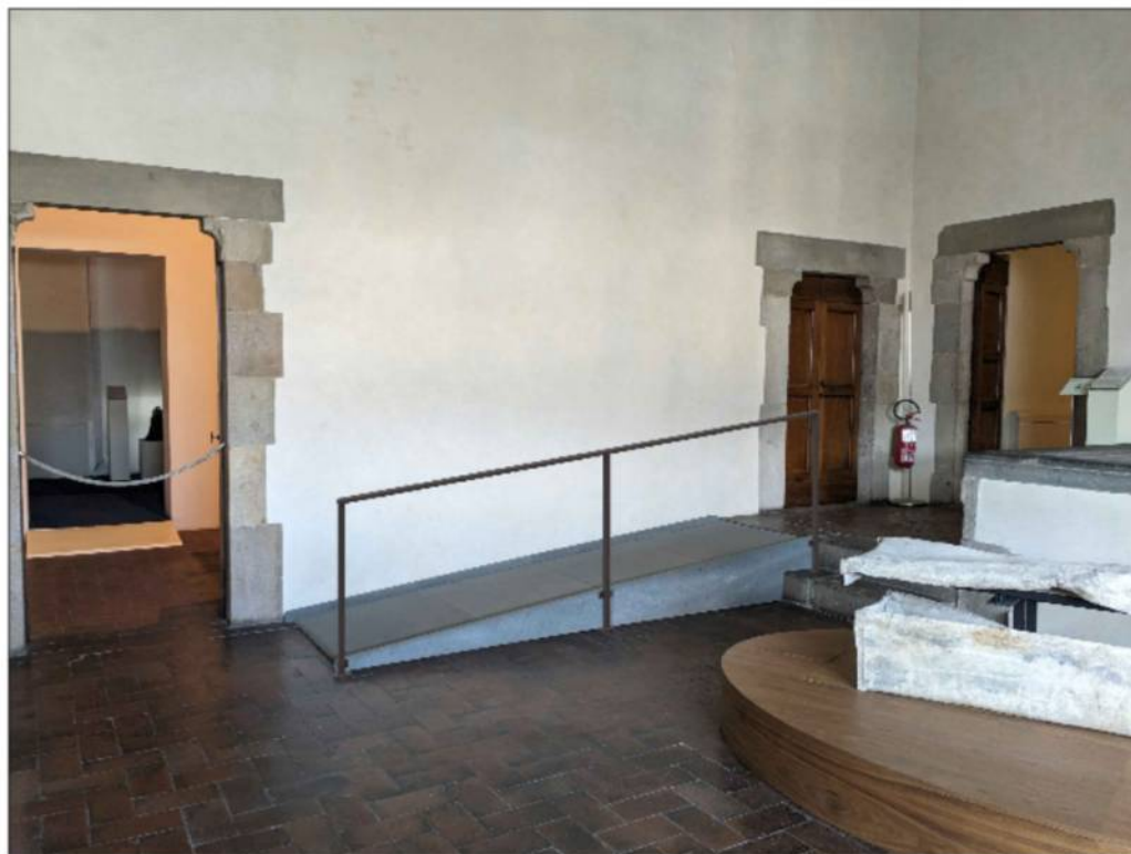
FOTOINSERIMENTO STATO DI PROGETTO - CORRIMANO RAMPA INTERNA
